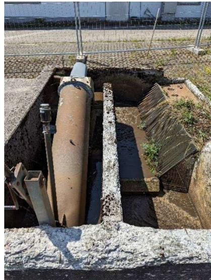
Abbildung 10 Schneckenpumpe.
