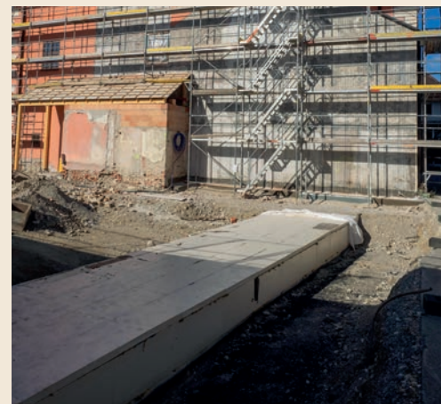
Unterirdischer Verbindungsgang zwischen Schloss und Mehrzweckgebäude
